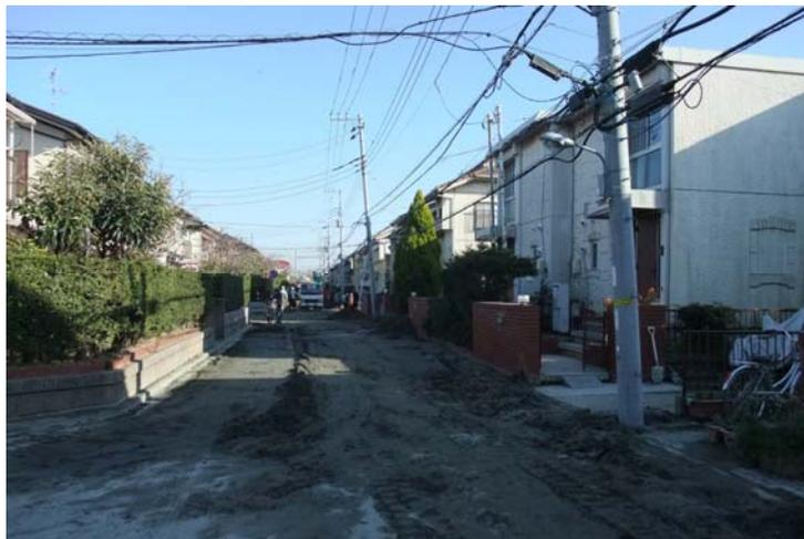
道路一面、噴砂で溢れ、電柱は沈んだ (千葉市美浜区)
