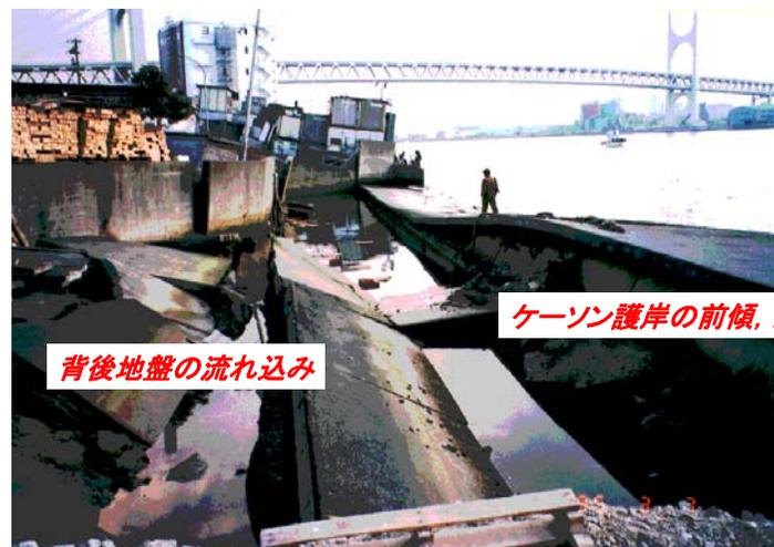
ケーソン護岸の前傾, 沈下
